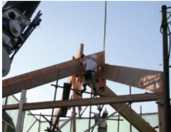
4本の登り梁が、互いに噛み合うラメラ架構として自立することで、柱のない空間を実現した住宅。その架構を現しにして、建築の構成のダイナミズムを隠蔽せずに、物を築く「初源的な情動」を住環境に残すことが意図された。
