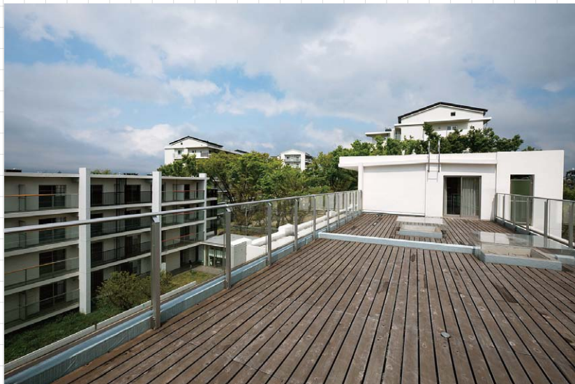
C棟屋上テラス(減築された部分)。
