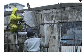
4階壁梁の解体。
