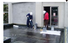
屋根防水工事。
