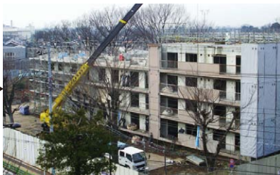
改修工事の様子。
