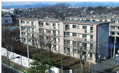
改修前のC棟。
