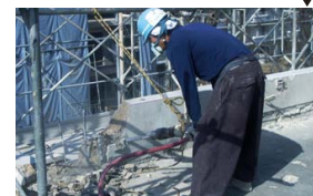
切断端部の補強・補修。
