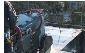
既存屋根の大割解体。
