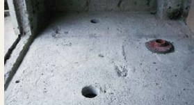
コンクリート打設用の開口。
