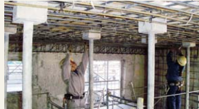
スラブおよび端部梁型の配筋。
