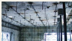
後施工アンカー打設。
