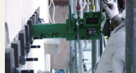
PC鋼棒緊張(100kN)。
