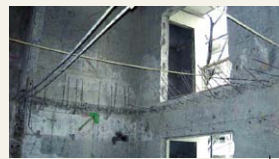
既存スラブ・壁・梁の解体。
