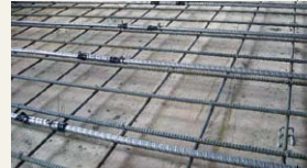
PC鋼棒設置。
