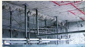
解体工事完了。
