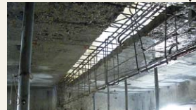
スラブの一部も撤去。
