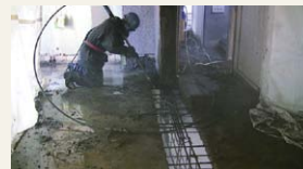
ウォータージェットによる解体。
