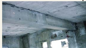
コンクリート打設後。
