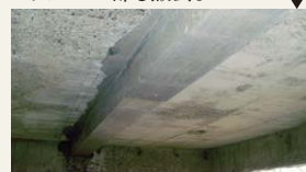
コンクリート打設後。
