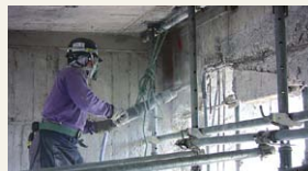
ブレイカーによる解体。
