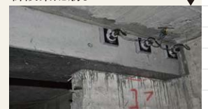
PC鋼棒緊張後。
