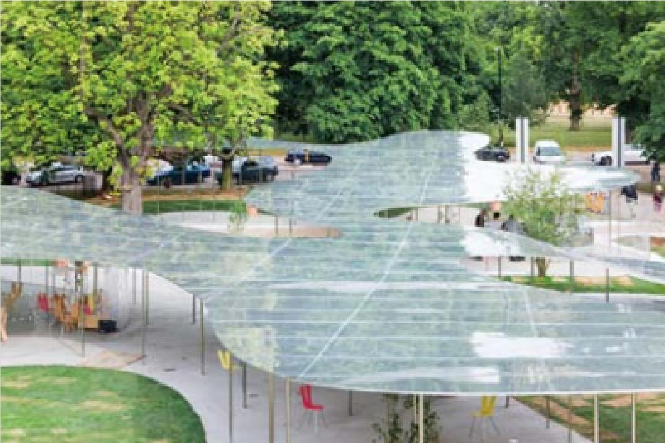
構造用合板を鏡面研磨仕上げのアルミ板で挟んだ屋根が、細い柱だけで支えられる（写真＝Iwan Baan）。
