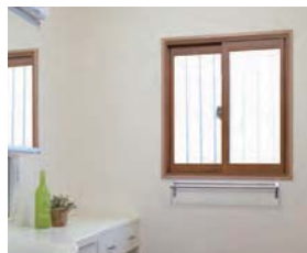
内窓設置：マドリモ内窓 プラマードU
