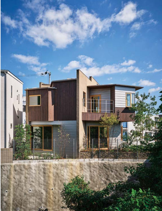
南側から見た外観。
