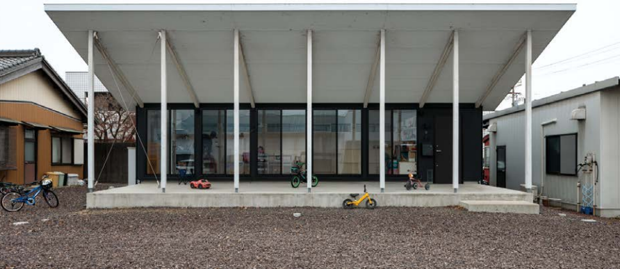
南側から見た正面外観。
