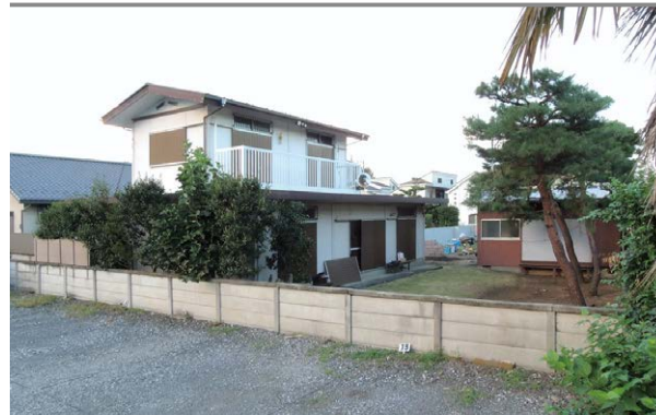
増築前の外観
