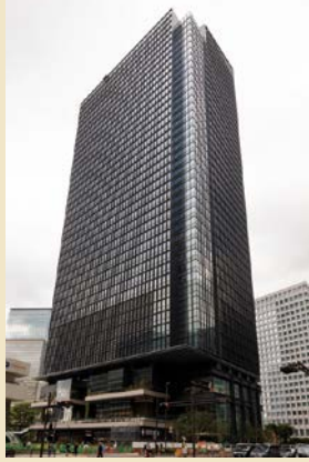
南西側から見た外観。
