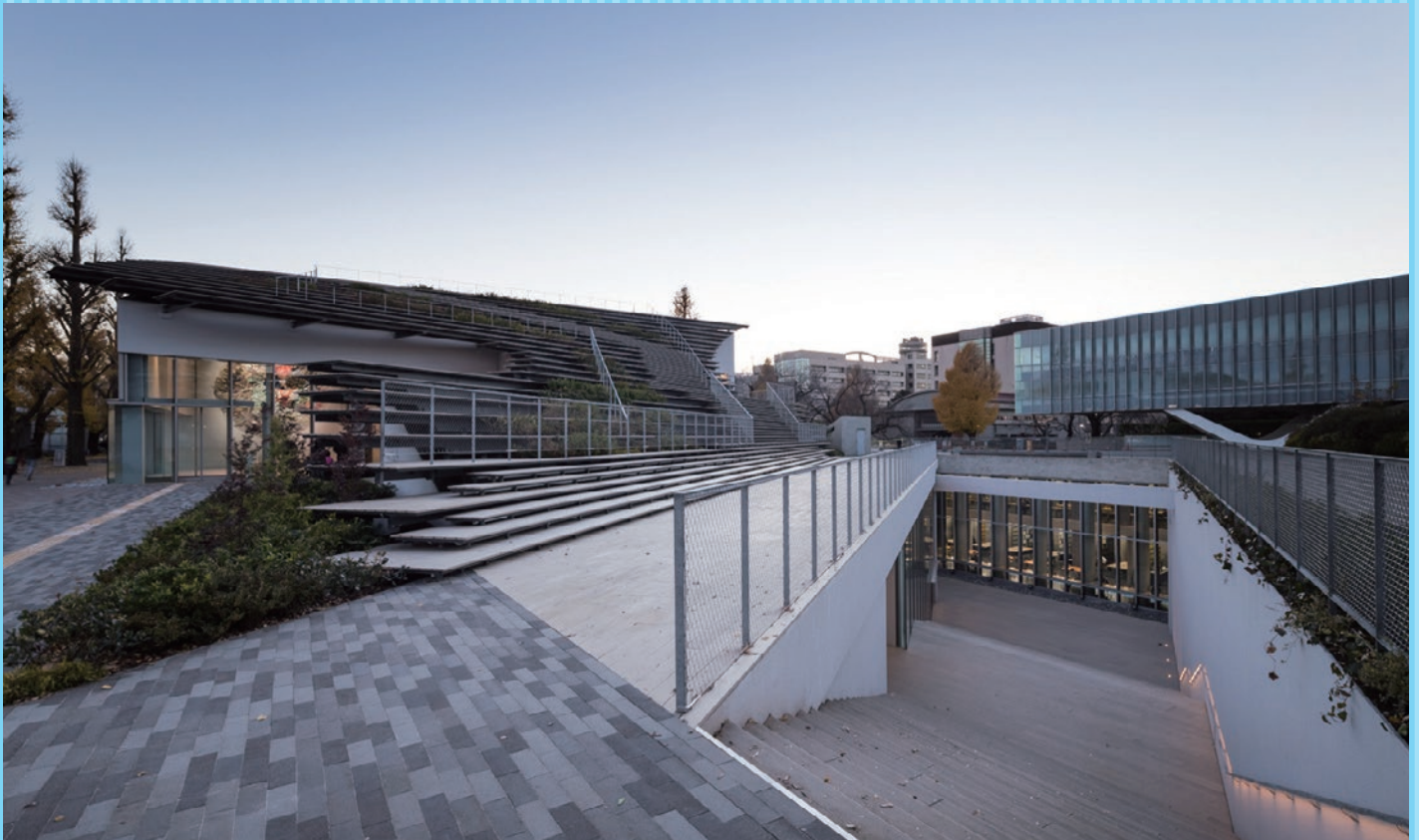
地下の図書館につながる大階段。左手に1階エントランス。
