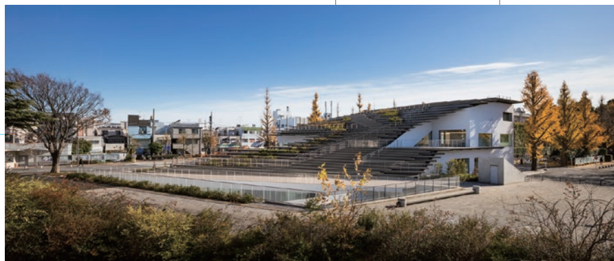
北側外観。 大岡山の丘を イメージした建築。
