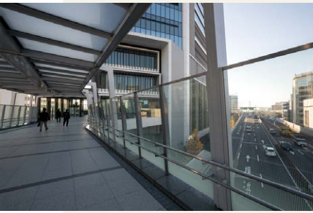
高速道路の上をまたいで架けられた駅とビルをつなぐ歩行者デッキ。
