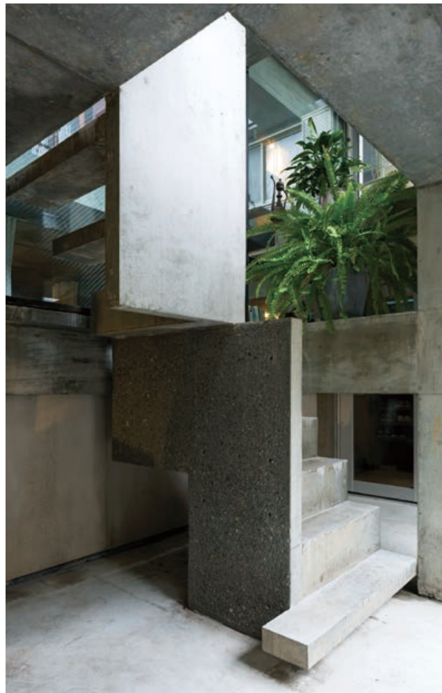
↑バルコニー1。耐力壁のないラーメン構造のため、開放的な吹抜けをたくさん確保できる。
