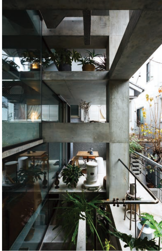
↑バルコニー1。耐力壁のないラーメン構造のため、開放的な吹抜けをたくさん確保できる。
