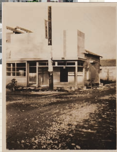
竣工当時の長屋。 キュービックでモダンな 建物だった。
