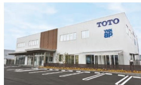
TY岡山コラボレーションショールーム外観
