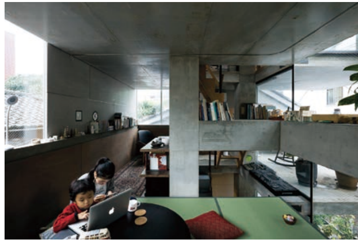
3階和室。スラブの位置と梁の位置が異なるため、梁が宙を飛んでいる。
