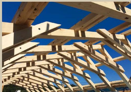
ユニットを並列させ、母屋材で固める。屋根全体として構造が成り立つ。
