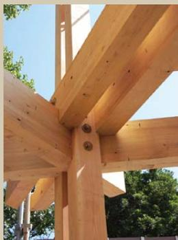
通しの「合わせ柱」と「合わせ梁」を組み上げた様子。
