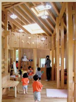
2階内観。「合わせ柱」が頂部に到達し、挟んだ梁で屋根を支えている。
