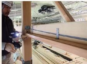
写真右／柱と鴨居の取り付け。柱と金物がボルトで連結されている。左／幕板の内側の溝に、鴨居をゆるませない円弧状の金物を取り付けている。
