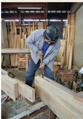
写真上/工房にて仕口を削り出し、仮組みまで行う。下/木目を見て、どのように削るべきか、上野さんと担当の棟梁が話しあう。
