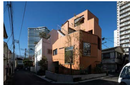
南東側外観。3方向が接道している敷地。1階の南側にはメインの玄関、北側には勝手口がある。
