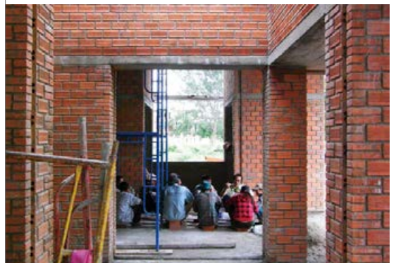
↓ 作業員は現場周囲に住み込む。食事の一コマ。
