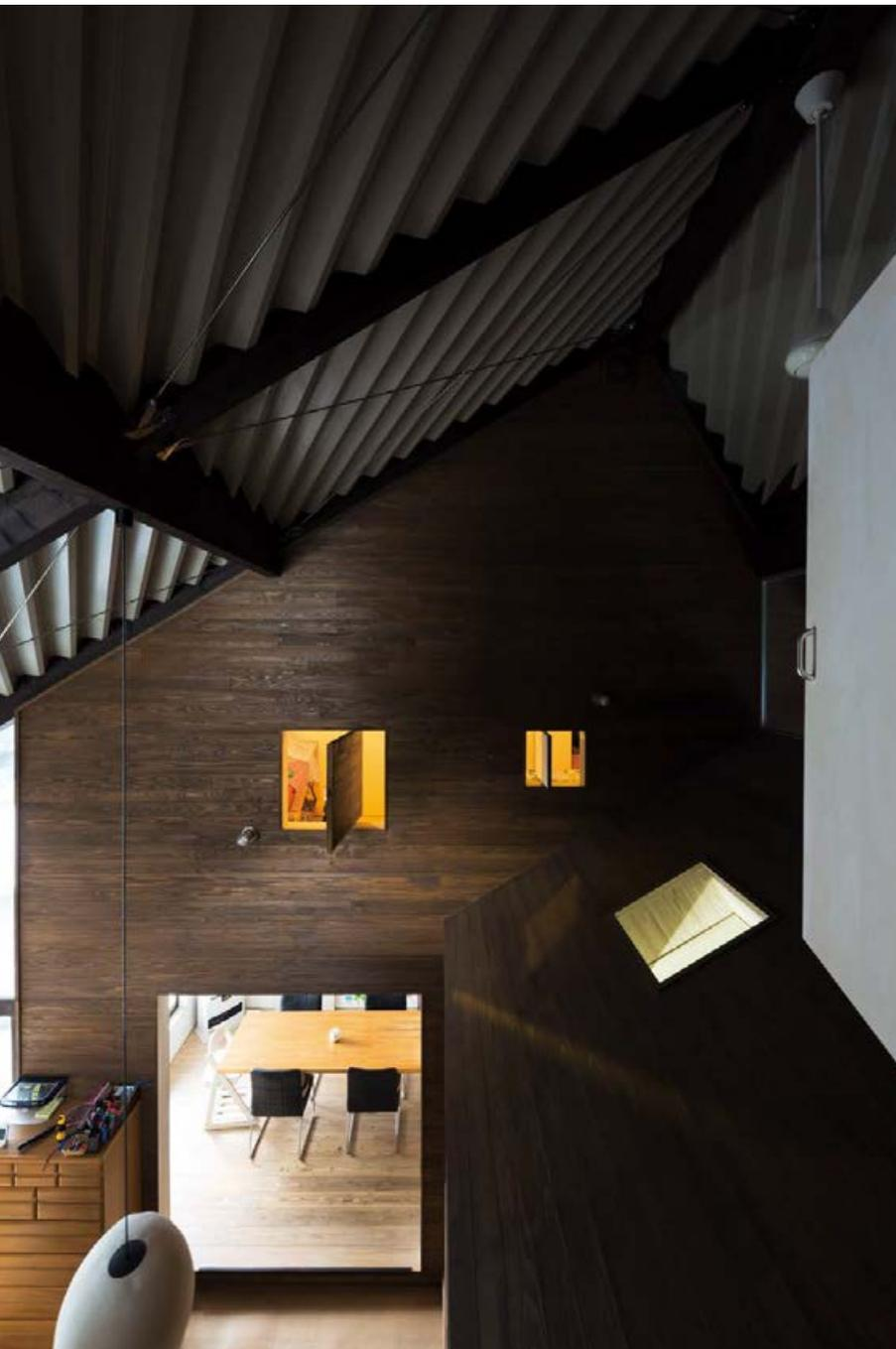
ダイニング・キッチンと子ども部屋のある小屋。大屋根では、折板のあいだに断熱材がサンドイッチされている。
