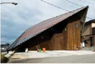
南側外観。屋根の折板は、周囲のいぶし瓦と石州瓦の屋根に合わせて2色にしている。
