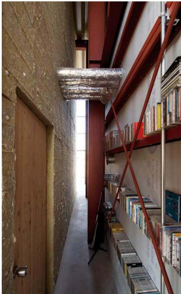
写真右上／外側と内側の建物のあいだの空間。露わになった鉄骨は物を置く棚にもなる。
