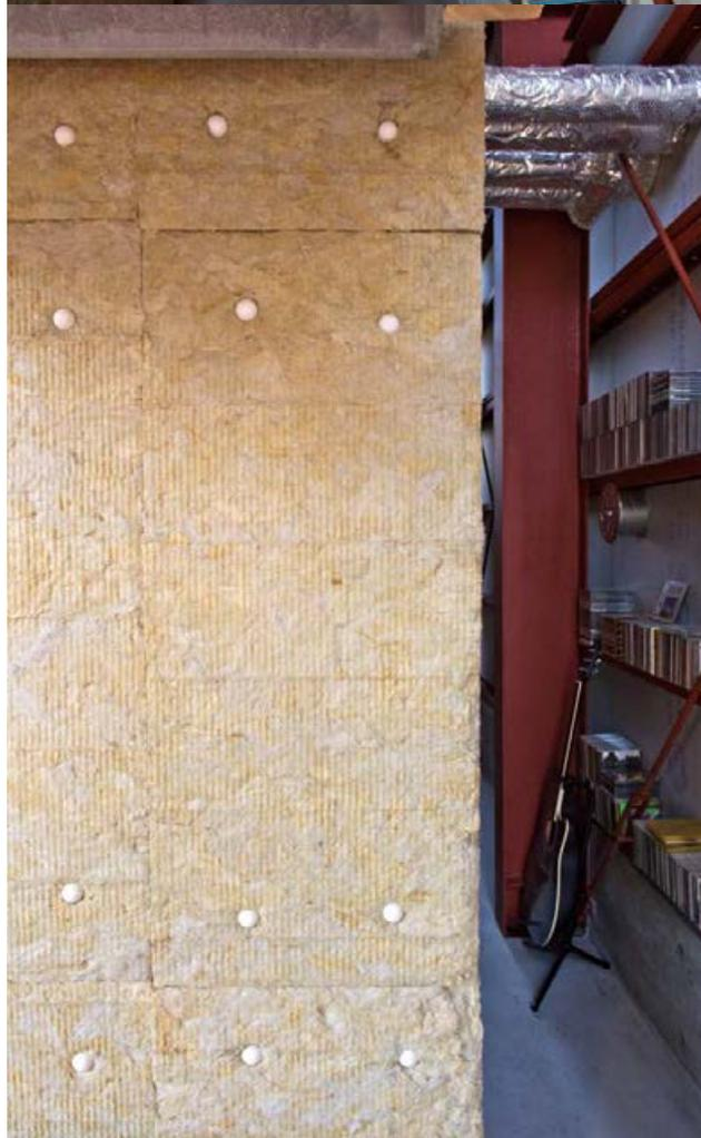
写真右下／内側の建物の外壁。断熱性能のあるボードが、そのまま仕上げ材になっている。
