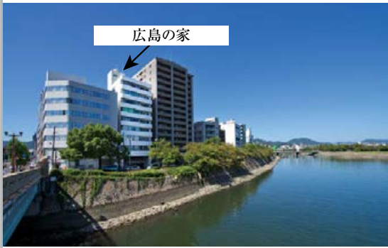
川沿いに建つビルのワンフロアが「広島の家」。
