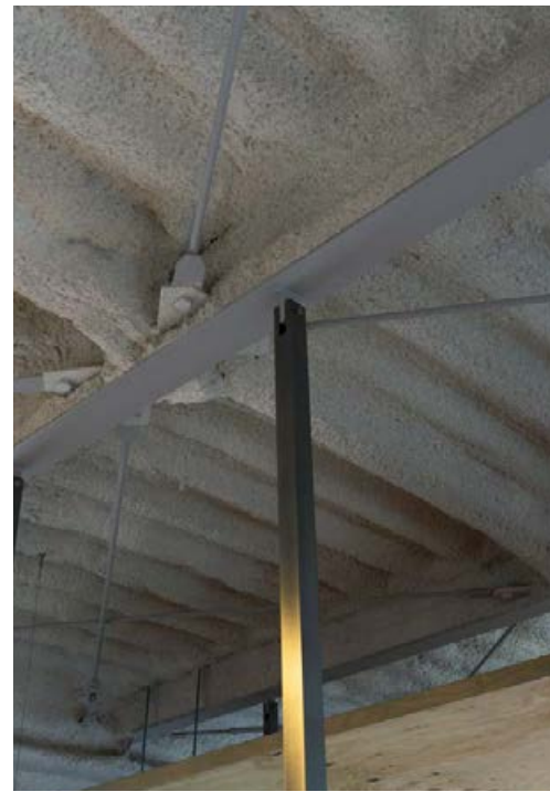
写真中／2階広間の床。写真上／既存の鉄骨に取手前から、磁器質タイル、フロリング、吹抜け部分にはネット張り。写真上／既存の鉄骨に取り付けられた小柱。将来の間仕切りや柵の支えのために設けられている。
