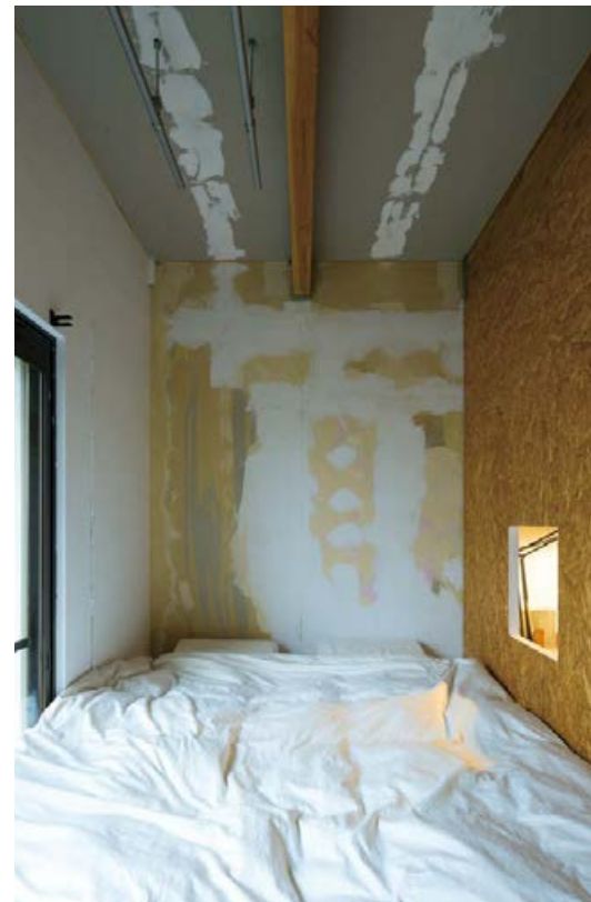
1階の寝室。補修部分やビス跡などを白色のパテ処理。
