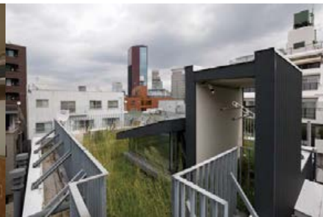
屋上。補助金を得て緑化し、笠木には高反射塗料を塗布することで、環境負荷軽減を行っている。
