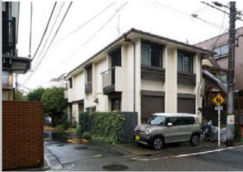
南西側から見た外観。今回の改修は内部のみで外部は手をつけていない。
