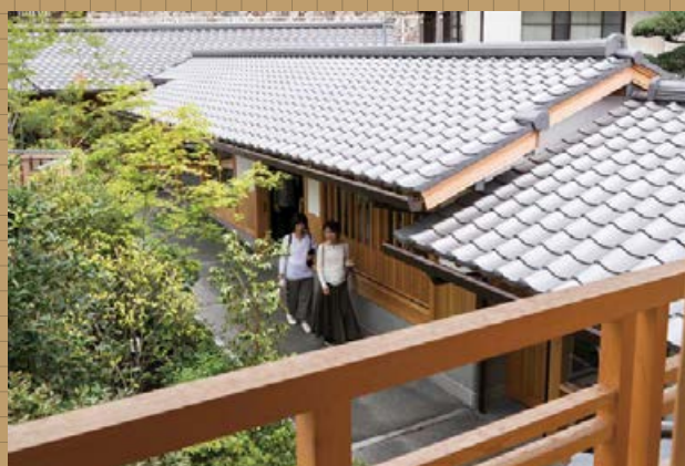
写真右下／2階テラスから通り土間を見下ろす。通り土間の上には、軒が深く張り出している。
