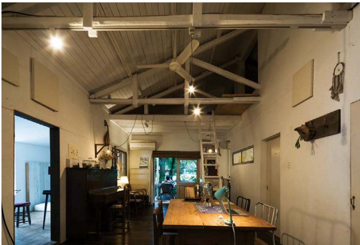
リビング兼喫茶店。奥はテラス。上部ロフトは住人による改修。トラスの小屋組みは当時のまま。
