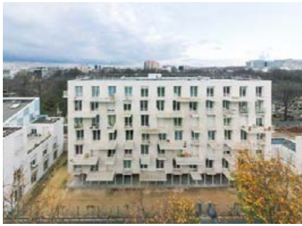
3. Logements Sociaux Rue Rebiere (フランス、パリ、2012年)
