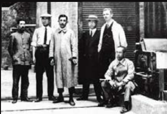
トンネル釜完成
