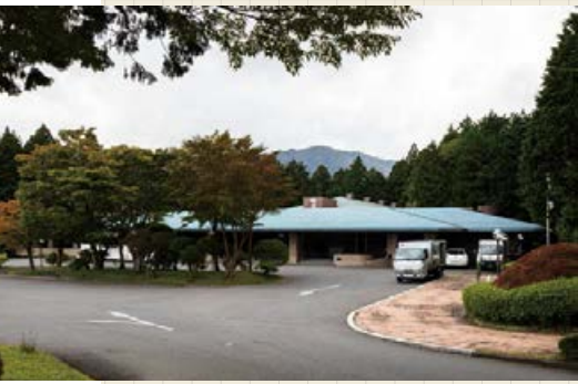
正面エントランス。軒が深く、屋根が低くおさえられた控えめなたたずまいになっている。
