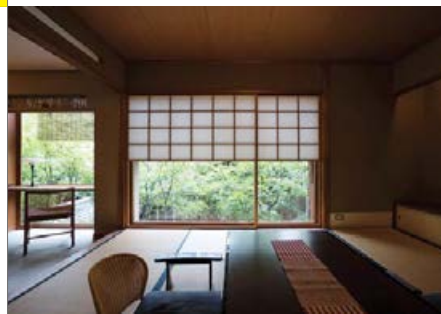
新館2階の客室。雪見障子は、框と組子の見付寸法を同じにした「吉村障子」。本館との境の緑豊かな庭が見える。
