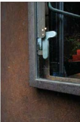
有害性ガスを出して燃えたりせず少し焦げるだけらしい。工場ですうしてつくった壁パネルを現場に運び、逃げを2mmとって立て並べ、最後に溶接して一体化する。
