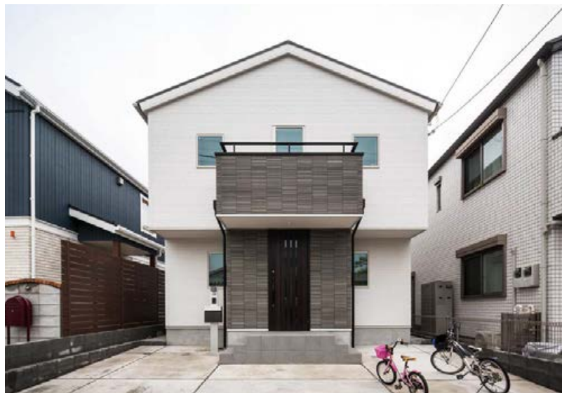
北側外観。外装材は標準的な建売住宅のもの。雨どいや窓がシンメトリーに配置されている。
