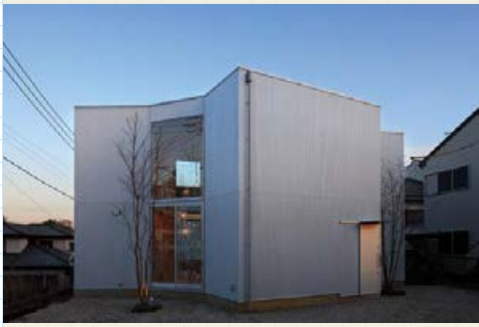
西側外観。高さ6mほどのユニットが配置されている。
