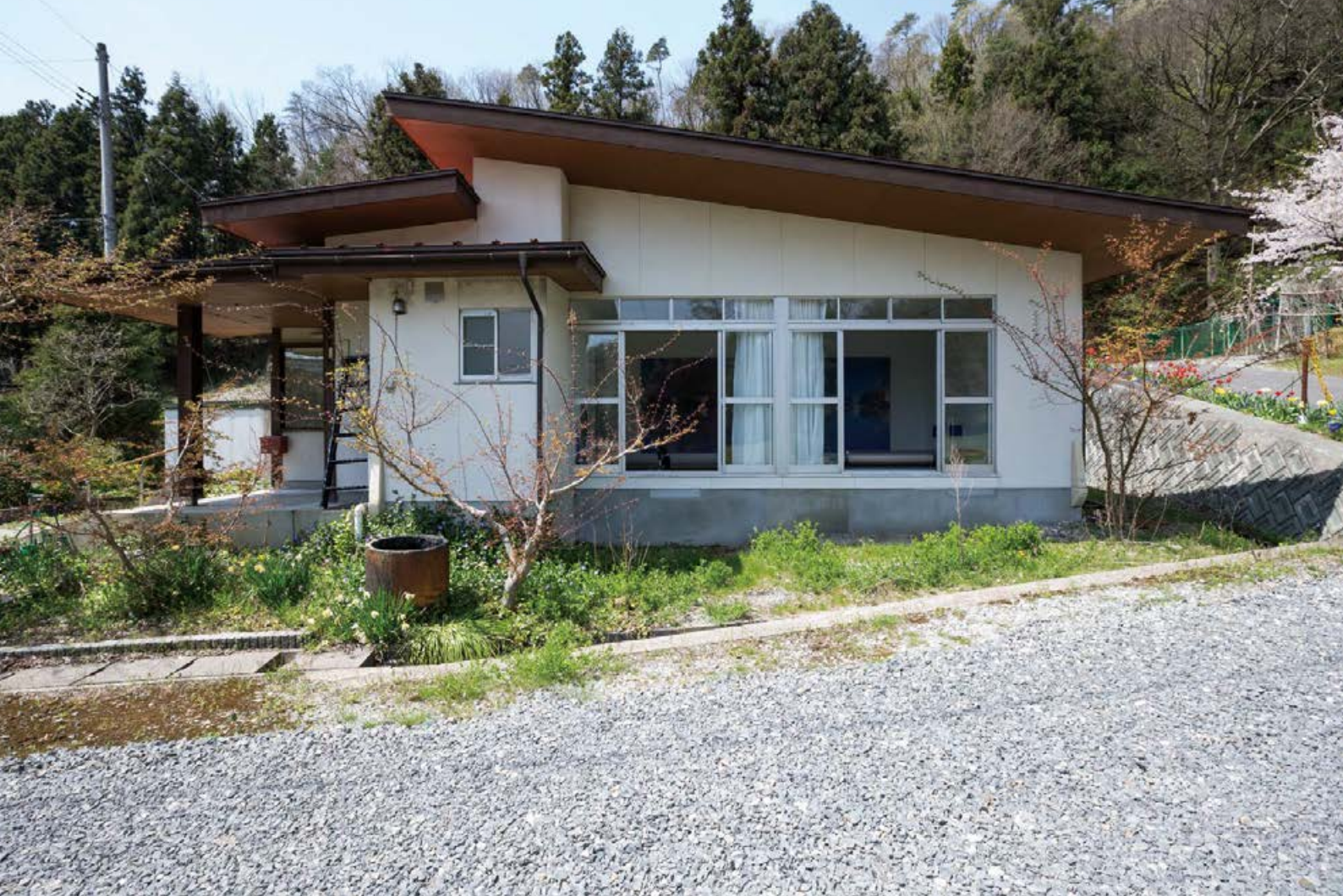
東側外観。正面にアトリエの窓。もともとの掃き出し窓が腰窓になった。
