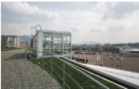
太陽光などから集熱するソーラーチムニー。100の環境配慮のひとつ。
