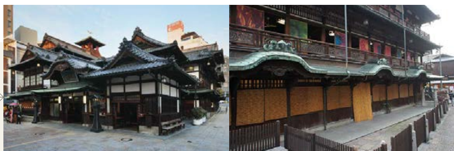
「道後温泉本館」 神の湯本館(右)・玄関棟(左)
