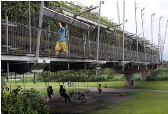
津梅橋遊歩道
