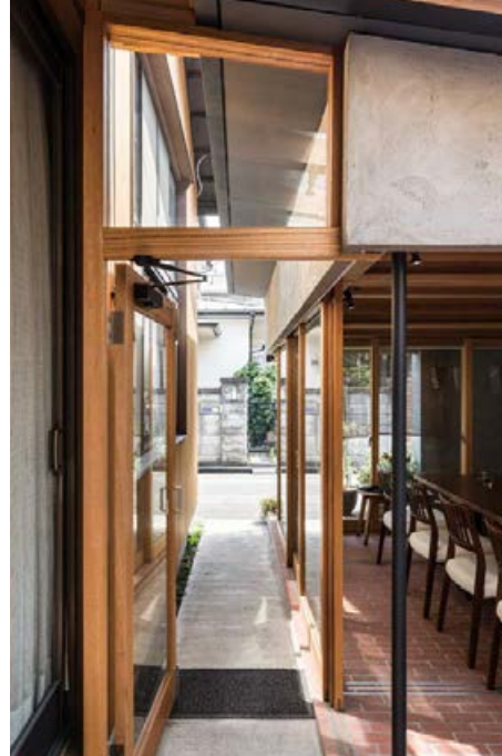
増築部のアプローチ
