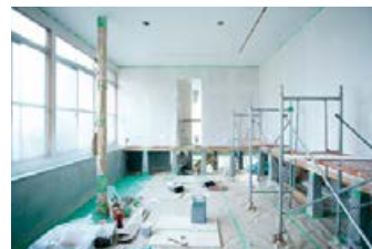
リビングブルー(施工中)
