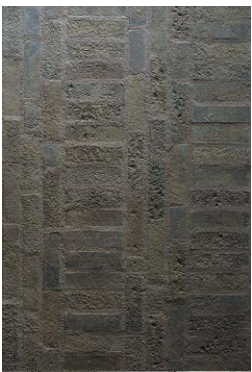
珞器質タイル張り
