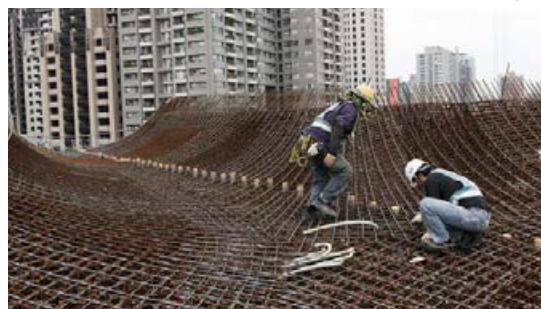
トラスウォール配筋
