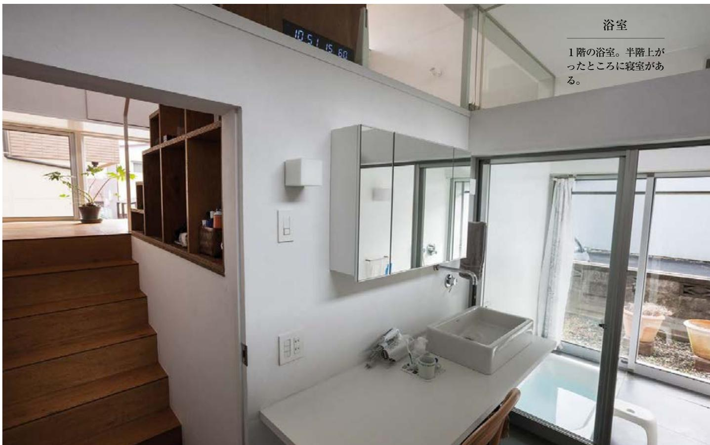
窓のサッシはポスト柱の後ろに隠されている。
