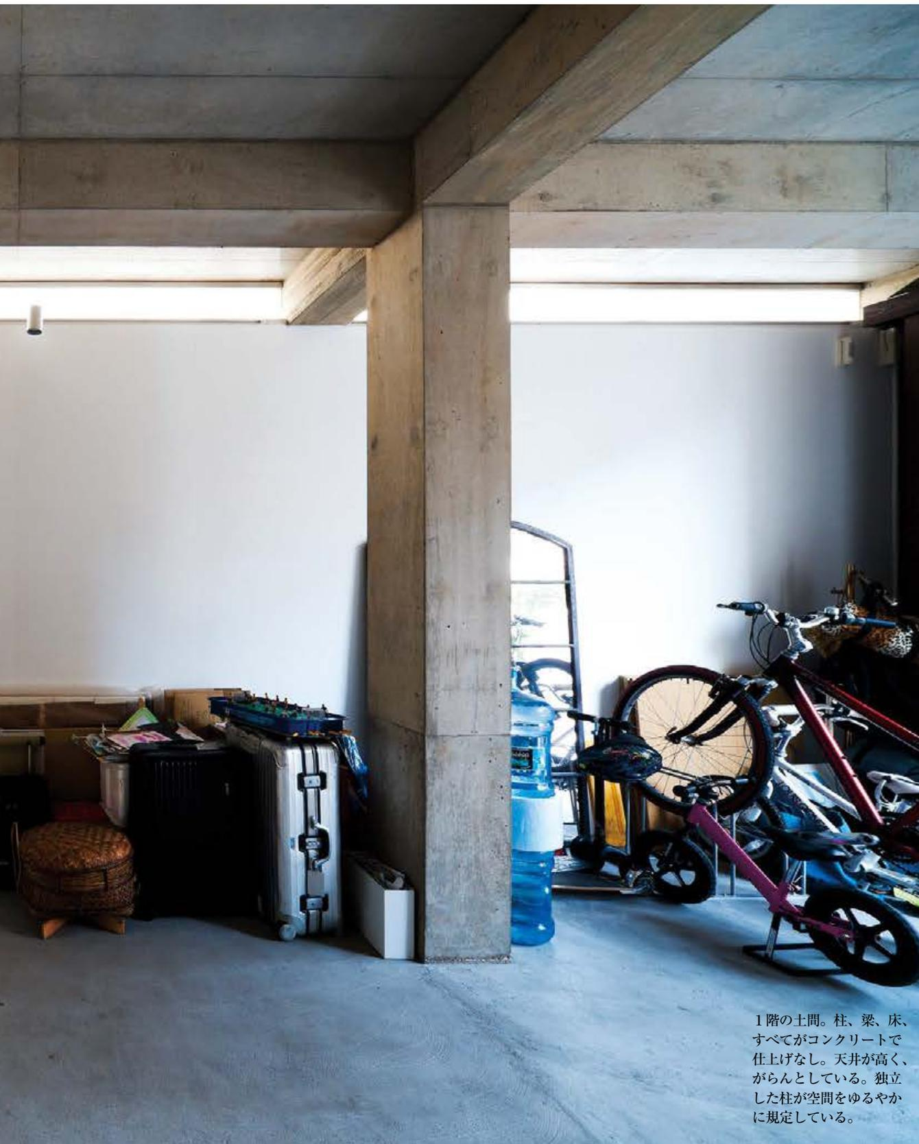
1階の土間。柱、梁、床、すべてがコンクリートで仕上げなし。天井が高く、がらんとしている。独立した柱が空間をゆるやかに規定している。
