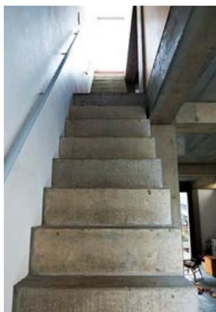
1階は仕上げを省いたコンクリート剥き出しの土間で、柱は両端の壁面から950mmほど内側に立っている。柱を通例のように外壁面に寄せて立てなかつたのは構造上の理由もあるが、それにも増して柱の内側を人が活動する空間、外側をゆるやかに規定する装置としたからだという。実際、こ
