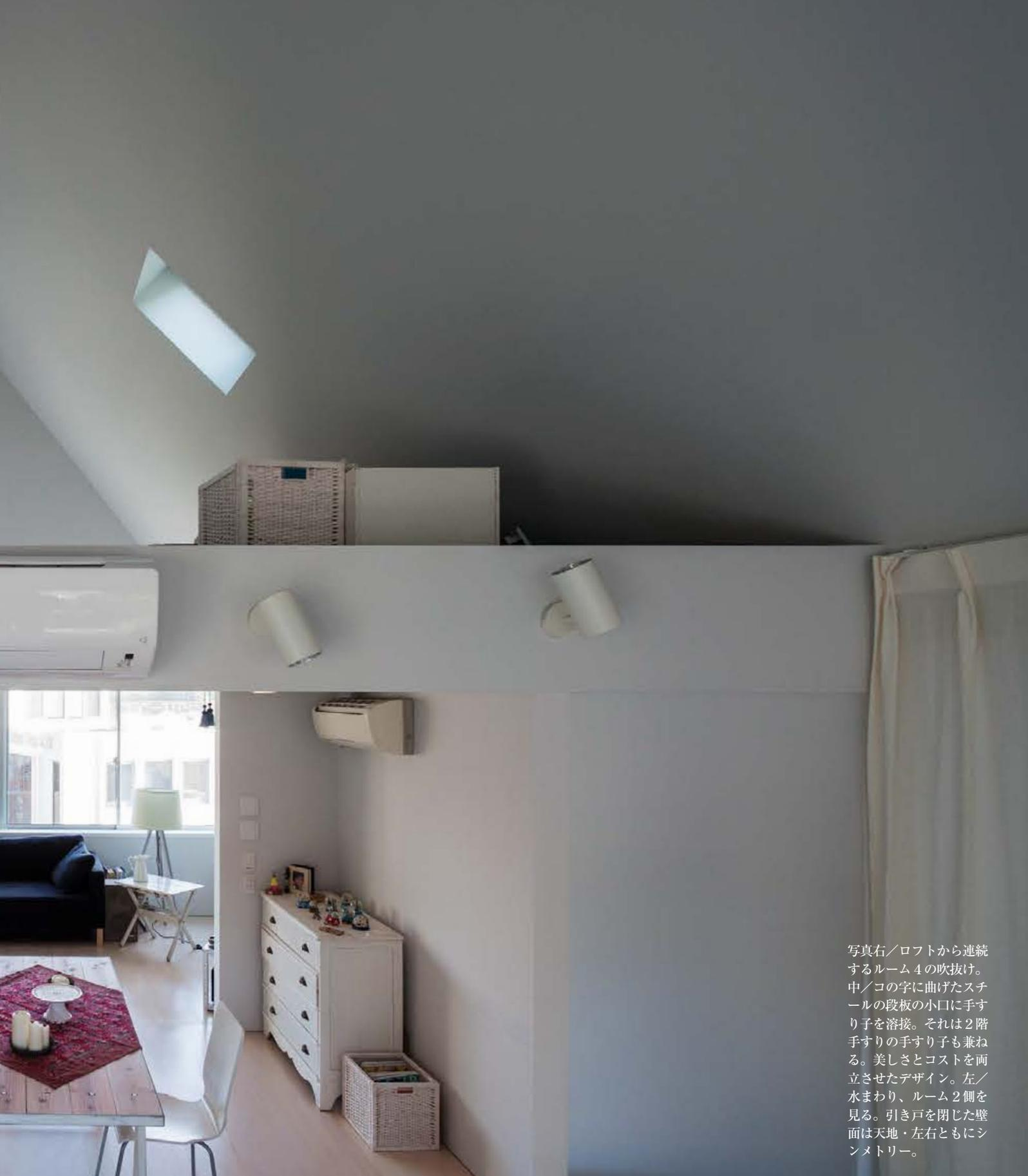
写真右／ロフトから連続するルーム4の吹抜け。中／コの字に曲げたスチールの段板の小口に手すり子を溶接。それは2階手すりの手すり子も兼ねる。美しさとコストを両立させたデザイン。左／水まわり、ルーム2側を見る。引き戸を閉じた壁面は天地・左右ともにシンメトリー。
