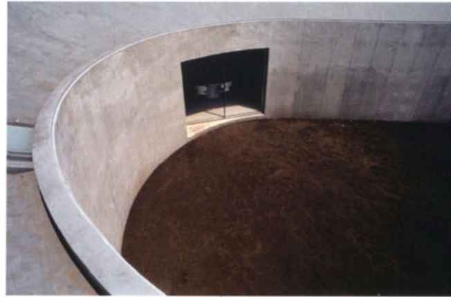
中庭と内部をつなぐ開口部はきわめて限定されている。正面開口部は食堂スペース。
