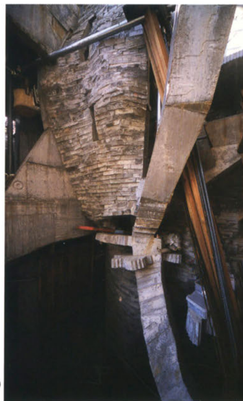
10 / 吹抜けを勢よく上昇する階段と籠。
