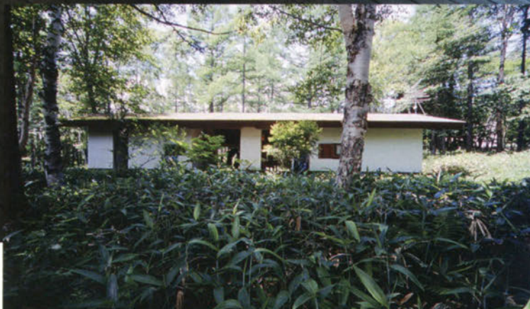
写真はすべて2008年撮影。 全面写真／手前ふたつの 箱は収納、奥は厨房のある 部屋。中央テラスに椅子と テーブルをセットすれば、 オープンな居間となる。右 /右手は厨房のある部屋。 中央は収納、左に風呂と トイレ。
