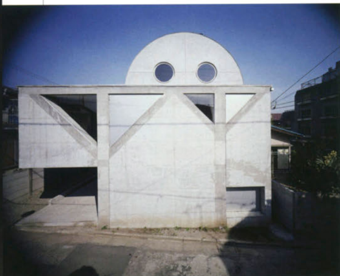
竣工当時の南西全景。三角窓は固定ガラスとアルミニウムフラッシュ戸の組み合わせ。
