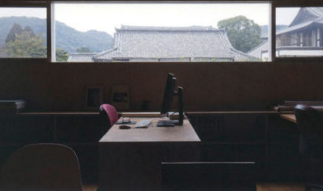
スペース2 東側の水平窓は開口高さ800mm、下端は床から1,350mm。
