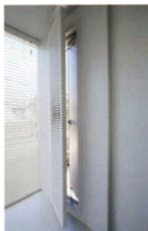
▲ 出窓の通風ルーバー
