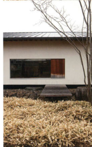
写真上／荒々しく豪快な石組みを渡って玄関へ。中／片引き吊り戸の玄関。板が壁にぶら下がるようなディテール（45ページ詳細図参照）。下／熊笹の茂み、株立ちの山桜、碎石、手水鉢、木のデッキ、地窓という構成。デッキは本体と一体化して床下からH鋼で持ち出し、鋼管杭140φ×1本で支持している。
