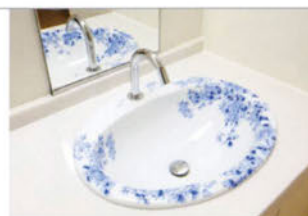
1階外来用トイレの洗面器。伊万里市 有田町ともに磁器の産地であることを生かした、有田の窯元の特注品。写真は男子トイレの洗面器。
