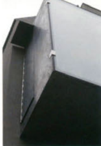
▲ 出窓側面の通風扉
