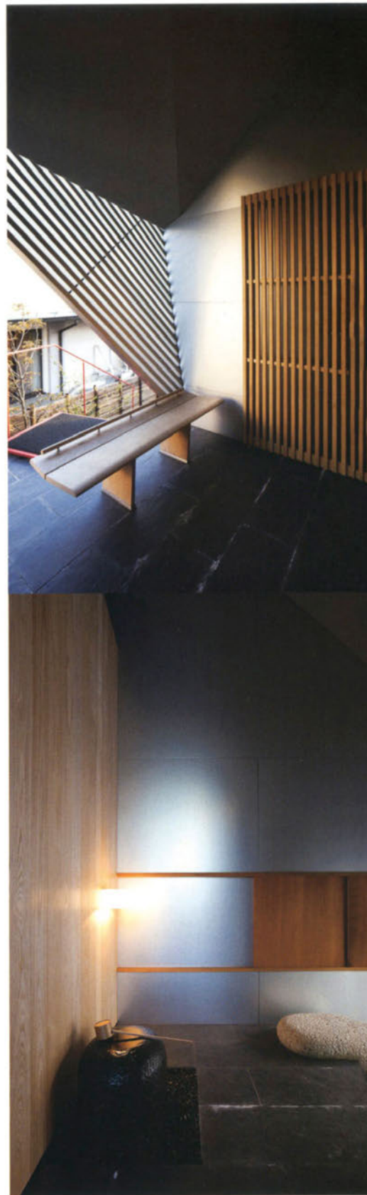
写真上／2階の待合ベンチ。右手の縦格子(引き戸)の奥は、アトリエの出入口で、茶事ではその存在が意識されないようにしてある。下／蹲はコンクリート製で小たたき仕上げ。灰墨と墨汁で着色されている。奥は躰り口。
