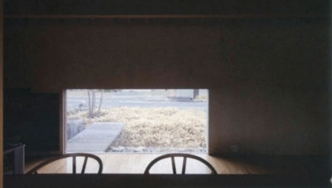
西側の地窓が庭の風景を切り取る。開口高さは1,150mm。
