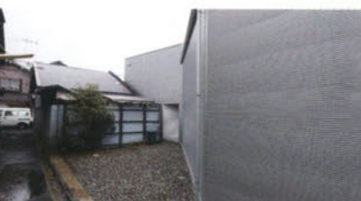
西側道路から北側を見る
