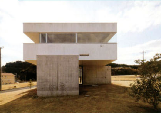
東側からの外観。2階の正方形ボリュームの下は、1階個室の軒下にもなる。
