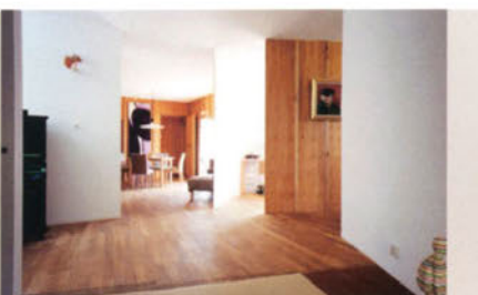
4人家族のための平屋の住宅。厚さ12mmの構造用合板で仕切られた放射状のワンルーム(外観写真：藤本壮介建築設計事務所、室内写真：阿野太一)。
