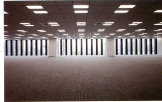
天井高2,800mm垂れ壁なしで、すっきり広々とした基準階オフィススペース。
