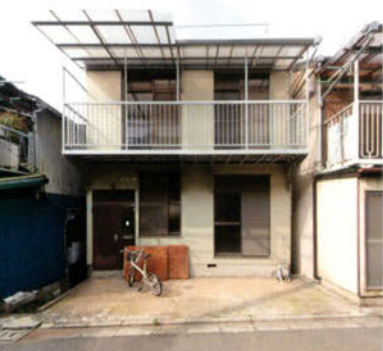
写真上／改修前の外観。築約30年の木造住宅（写真＝河内建築設計事務所）。左ページ／ファサード見上げ。1階事務所入り口と2階住居への外階段。
