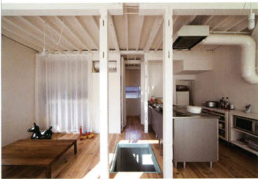
2階のリビング・キッチン。ダイニング・キッチンも耐震補強されている。正面奥に3階へ上がる階段（既存）がある。
