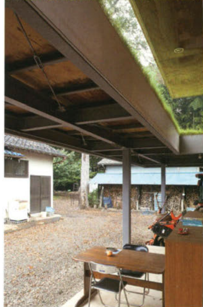
写真上3点/車庫は鉄骨造。木造の住居部分とは900mmの隙間をとって、構造的に緑が切られている。本体（住居部分）の軒天に張られた塩ビ板に芝が映り込む。
