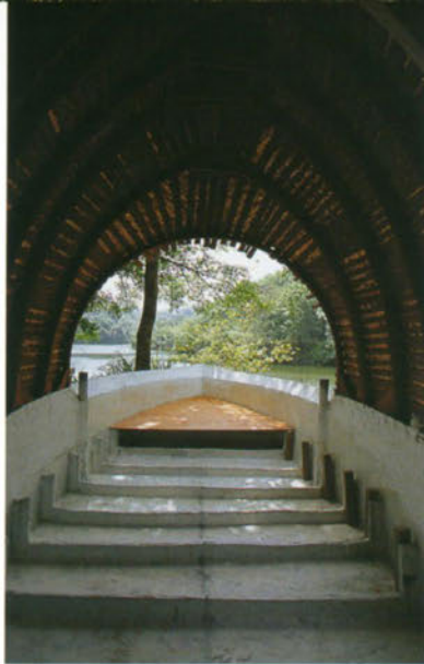
写真上／森のなかにたたずむ舟の茶室は、進水の日を待っているようで愛らしい。下／内部から眺め越しに湖を望む。すのこをはずすと、スタイロフォームとモルタルのモノコック構造が出現。
