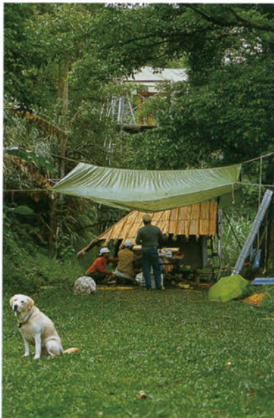
雨の現場。奥に竹の支柱の上部が見える。
