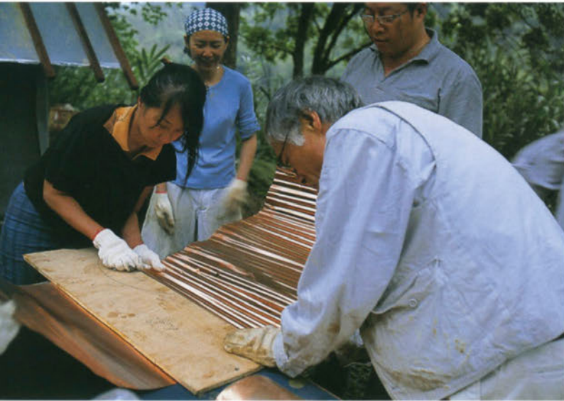
写真右／銅板を下から重ね張りしていく。隙間がないと毛細管現象で雨水が逆戻りするため、このぐらいのアバウトさがいいという。左／ひたすら山折り谷折りを繰り返して折り返しをつける、気の長い作業が続く。
