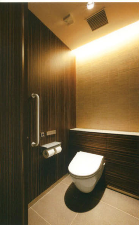
男子トイレの壁面は落ちついた色調の木調シート張り。便器は壁掛式便器（レストルームアイテム01）。
