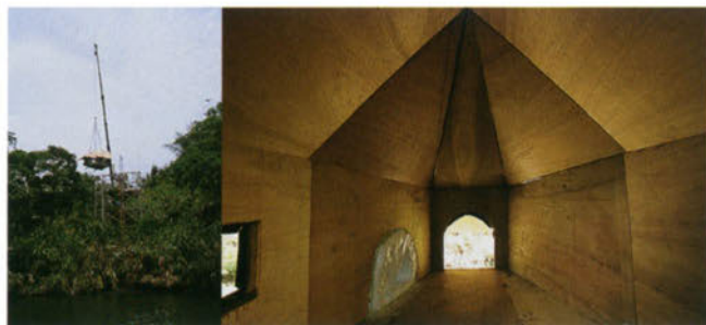
写真右/下地の合板を張り終えた竹の上の茶室内部。左に広さは2畳。はしこから入る正面の欄り口からクレーン/いとも簡単に茶室を吊り上げられた。
