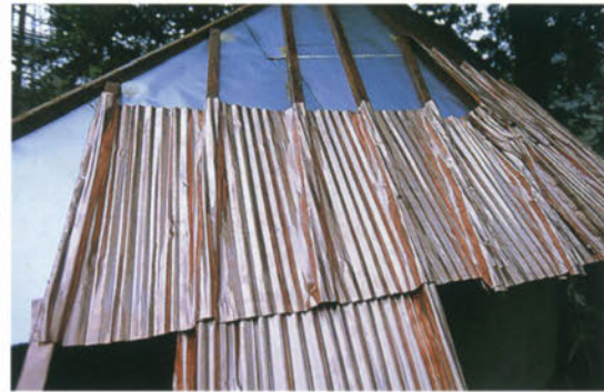
写真右／銅板を下から重ね張りしていく。隙間がないと毛細管現象で雨水が逆戻りするため、このぐらいのアバウトさがいいという。左／ひたすら山折り谷折りを繰り返して折り返しをつける、気の長い作業が続く。
