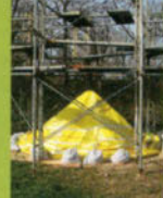
空気膜型枠の設置。
