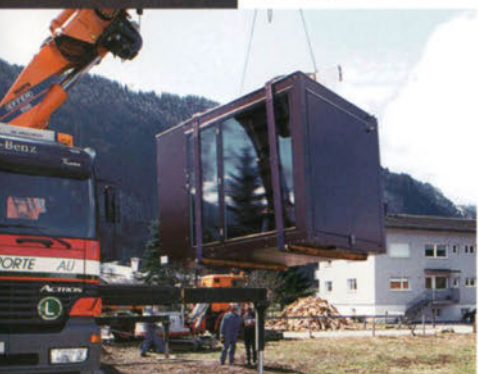
トレーラーから荷下ろし中のFred。たたまれた状態。現場では2時間の工事で設置が可能。
