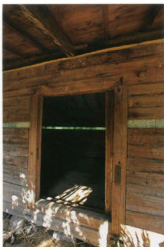
写真上下/八ヶ岳山麓は冬の寒さがきびしく、霜が降りるのを防ぐため、軒を延ばした建物が多い。軒下で作業したり、物置として使う。移築前は、軒先に味噌蔵が続いていたそう。写真左ページ/芝屋根の土は、この敷地にあった小山のもの。オリジナルの置屋根形式を踏襲している。
