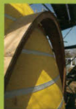
開口部枠となる木製リブ型枠の設置。
