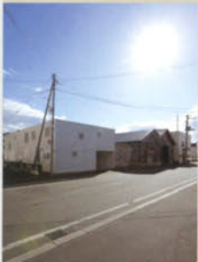
北東側外観。北海道の東、佐呂間町の古い市街地に位置し、交通量の多い道路に面している。右手の切妻の建物は農協の倉庫。
