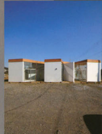
写真上／西側外観。屋根は陸屋根で、仕上げは耐水合板にFRP防水。L字壁は内外ともに同一の漆喰仕上げ。写真下／東側外観。
