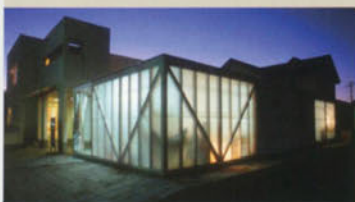
写真上／西側外観。半透明の壁は、ペアガラスをポリカーボネートの小波板で挟んだトリプルスキン。断熱性能と拡散光の取り入れを両立させた。写真下／南東側夜景。
