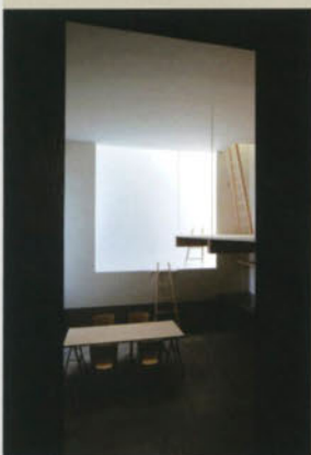
写真上/北西側外観。写真中/南東面に設けられた細い吹抜け。両サイドのガラス面から光を取り込み、壁で拡散された光を室内に届ける。写真下/玄関側から見る。白く光る四角の開口部(ガラスは入っていない)の奥が吹抜け。
