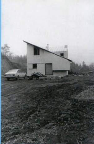
竣工したばかりの「新座の家I」が赤土の台地に立つ。
