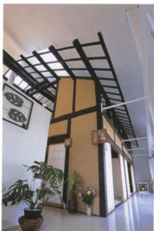
写真下右/浴室入り口前から南側を見通す。下中/室7上部。棟梁が右手壁面を貫通する。下左/玄関からの見上げ。右手鉄骨梁から持ち出したバーで木造部を支持している。
