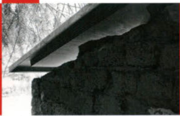
4 / 既存の外壁と新しい屋根。屋根面は極力薄く、シンプルに。
