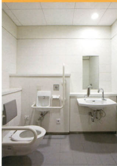
多目的トイレ
