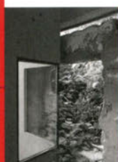
7/入り口ドアのある壁には、石壁の開口部が投影されたようなコーナー窓がつけられ、新旧の関係性を強調している。
