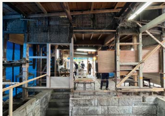
工事中のつなぎ棟と地下倉庫。
