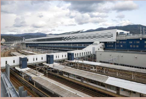
外観。在来線と通路でつながっている。
