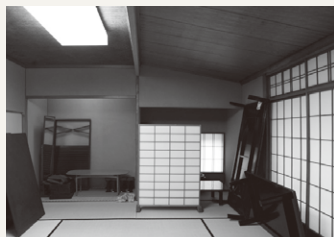
改修前の客室。質素な造りの客室であった。
