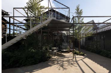
庭から屋外テラスを見る。
