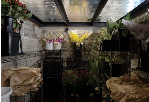
写真右／リニューアルした花屋(明治棟)。カウンターテーブルは新しくデザイン・製作された。下／明治棟と戦前棟に挟まれたつなぎ棟。現在は花屋の作業場として使用。左／大谷石で囲われた地下倉庫。天井はガラスに変更された。
