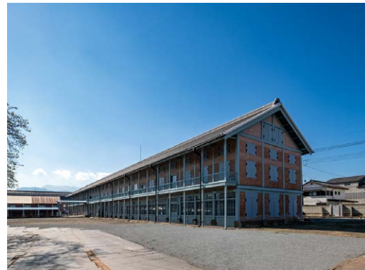
西置繭所全景。1872年に建てられた木骨煉瓦造の国宝建築。全長が100m以上あり、製糸場における繭の保管倉庫として使われてきた。
