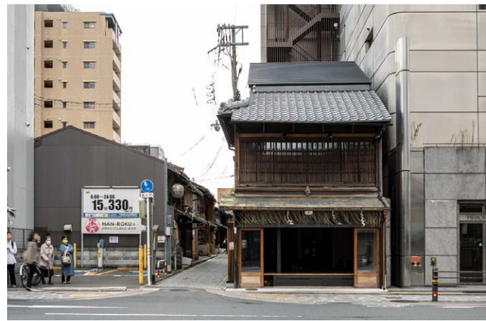
四条通からの外観。左の小径が青葉辻子。周囲には中高層建築が立ち並ぶ。
