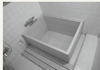
改修前の浴室。風呂桶は木製。
