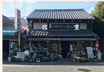
改修前の花重。左が作業場として使われていた江戸長屋。
