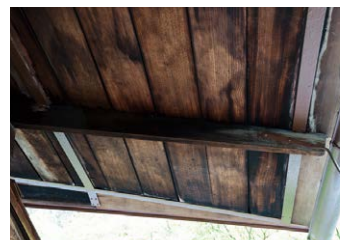
木造を鉄骨で補強することで軒先の薄さを実現している。
