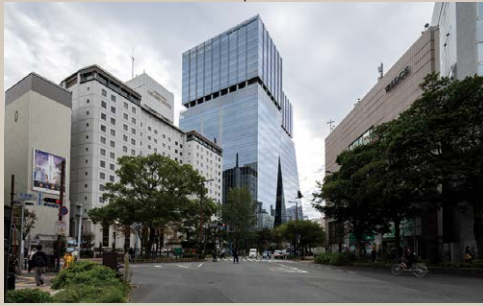
道路側から見た外観。
