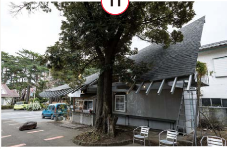
「敷島のパン屋」外観。
