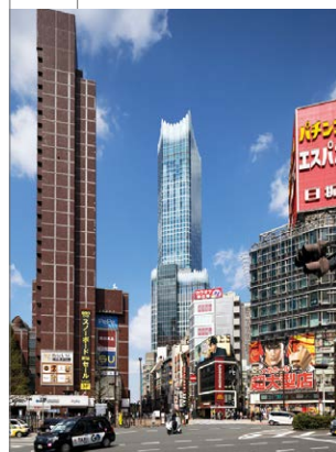
南側から見た外観。
