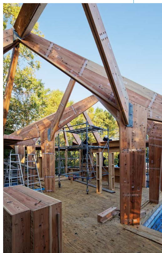
主架構となる構造体「ベッキュー」を1間おきに配置していく。
