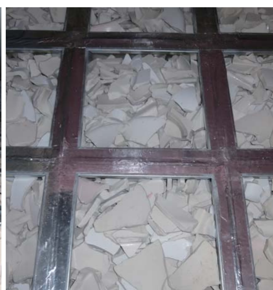
陶片蓄熱槽内
