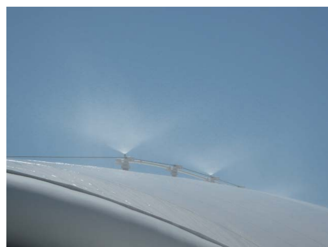
屋根散水の様子
