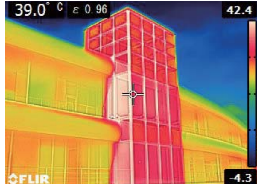
サーモカメラによるソーラーチムニー内の温度
