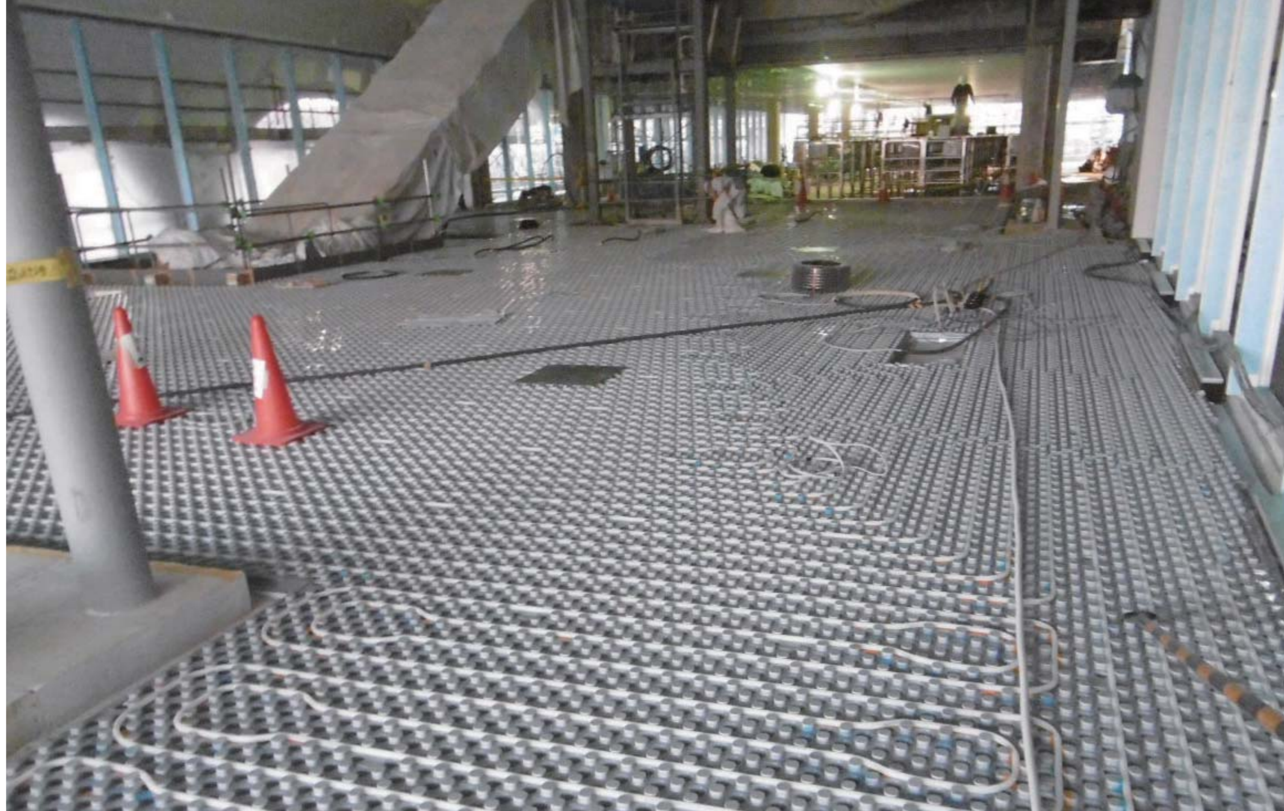
床下の配管施工時
