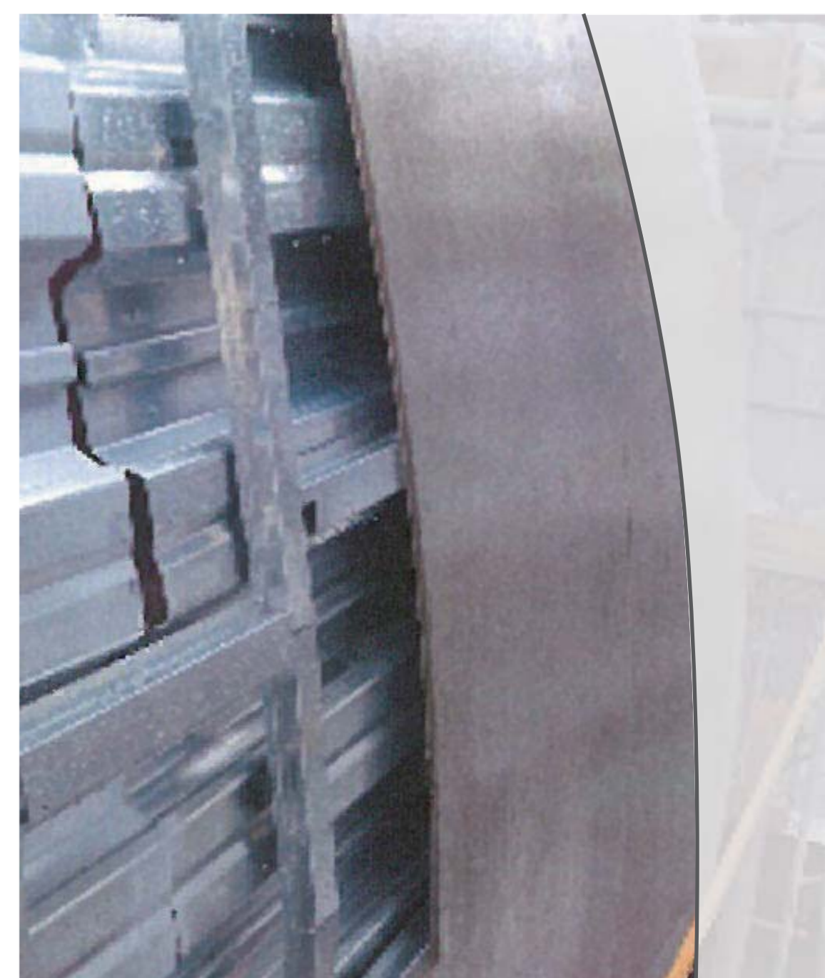
ダブルスキンルーフの断面構成
