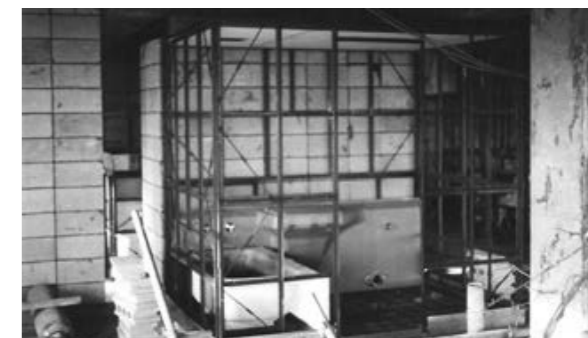
現場での組み立ての様子
