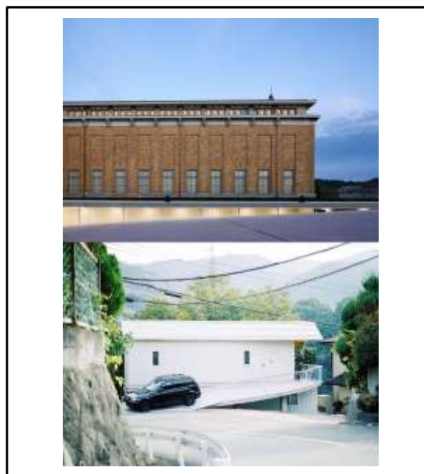
[2] 上: 京都市京セラ美術館 © Daici Ano 京都府 | 2019 | 青木淳建築計画事務所と共同設計 下: 西宮の場合 © Shin Hamada 兵庫県 | 2016 | 酒井真樹・安藤僚子と共同設計
