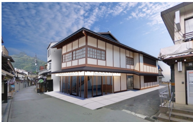
「TOTO 宮島おもてなしトイレ」外観 ※イメージ 景観条例に基づき、宮島の街並みに調和した伝統的な木造建築
