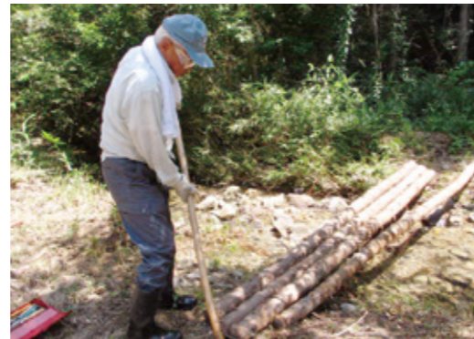
丸太橋の点検作業
