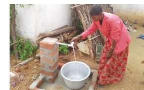
居住地で家庭敷地内に接続した設備の水流を確認
