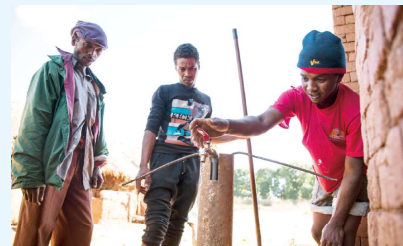
配管工による給水パイプの接続(マダガスカル)
