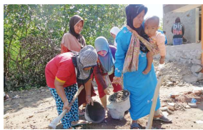
2校におけるトイレの建設作業には、多くの保護者が協力
