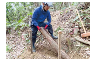
間伐した木々で作った階段(製作途中)
