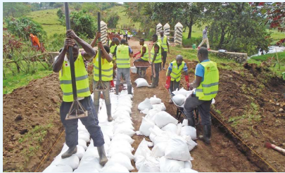
若者に対する土のう道直し訓練(ブヤンガブ県)
