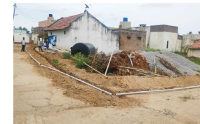
水道管の敷設作業
