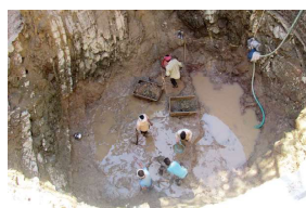
古井戸の蓄積した泥などを掻き出す
