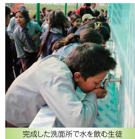
校舎裏に設置された水道
