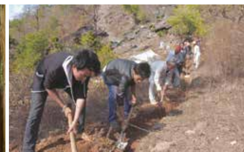
パイプを引くための溝を掘る村の人々(ネパール)
