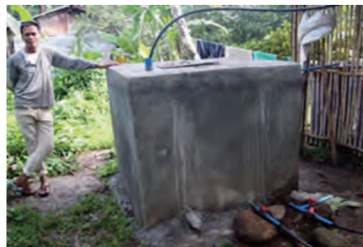
ホースで水を配水している様子
