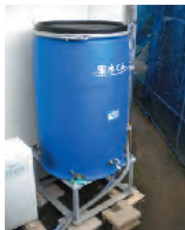
モニター宅に設置する雨水タンク
